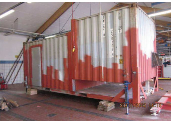
Ausbau AB Brand-Übungs-Anlage
