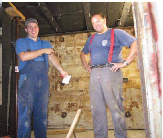
Ausbau AB Brand-Übungs-Anlage
