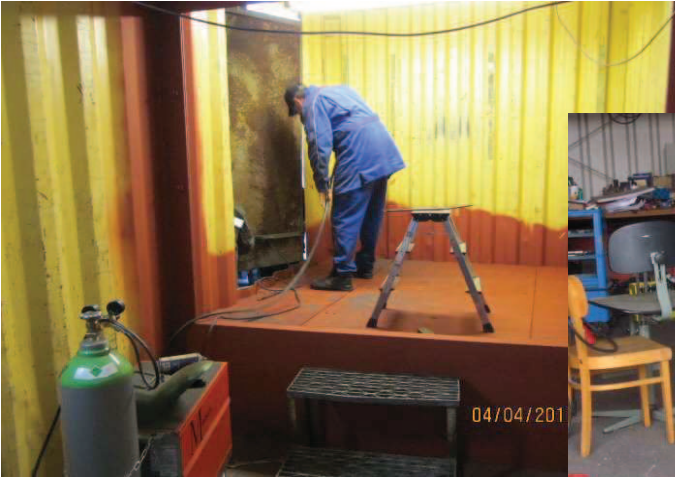
Ausbau AB Brand-Übungs-Anlage
