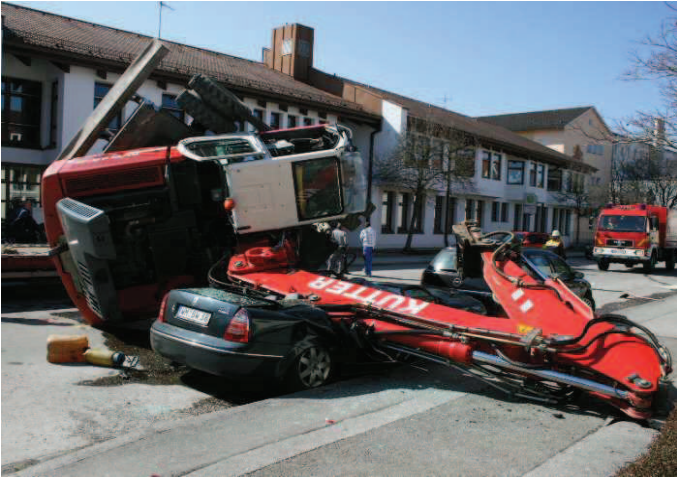
23.03. Umgestürzter Bagger Johann-Baur-Str
