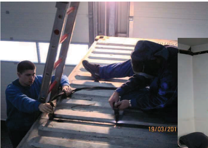
Ausbau AB Brand-Übungs-Anlage
